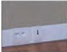
Les plinthes permettent, quand à elles, de faire cheminer les conducteurs au bas des cloisons.
